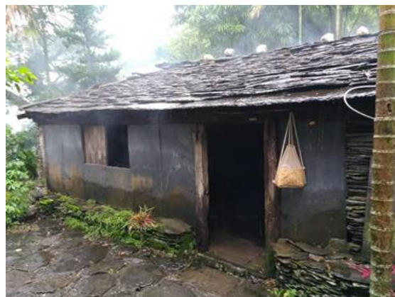
圖 2、老七佳部落的 kasintalj 地板鋪設工程
