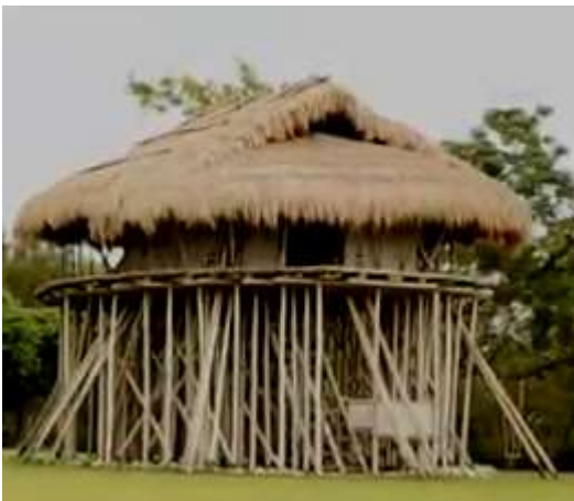
挑高式的少年會所 (槓桿原理與八組斜支撐的米字型)
