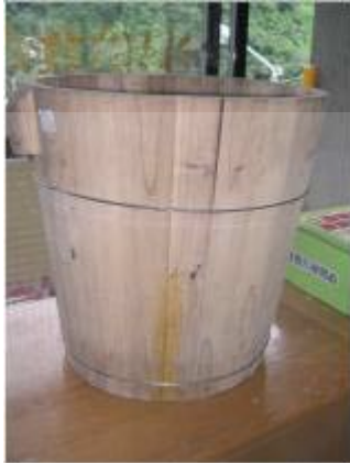
圖五：填補完後，蒸桶又完好如初了。
